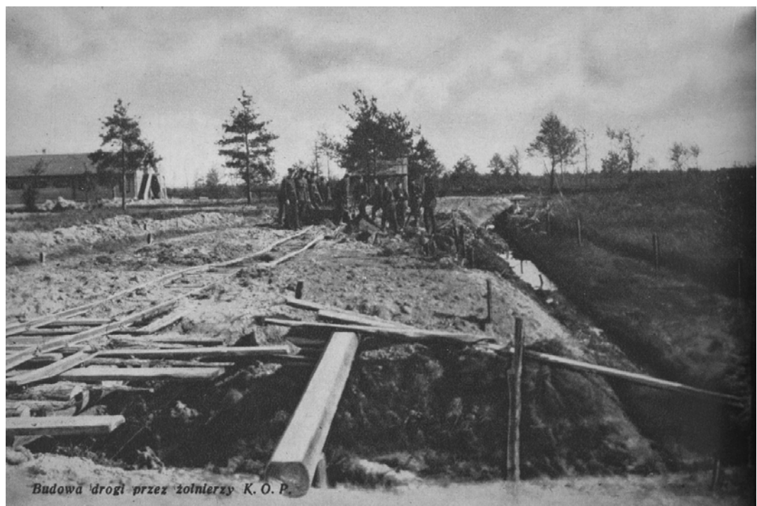
Budowa drogi przez żołnierzy KOP
